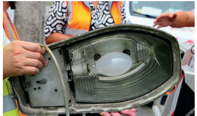
Ancien luminaire Sodium haute pression (SHP) déposé dans le cadre du programme LED++
