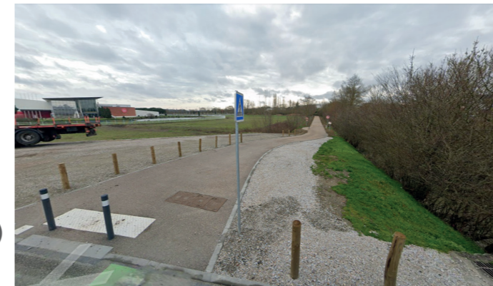
Passage d'une voie cyclable en bord de cours d'eau (Saune à Quins-Fonsegrives)
